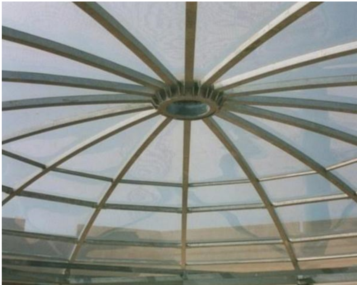
Esempio di copertura trasparente realizzata con lastre Macrolux® Solid
